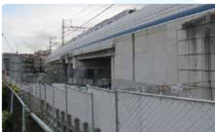
近接施工に伴う動体監視
