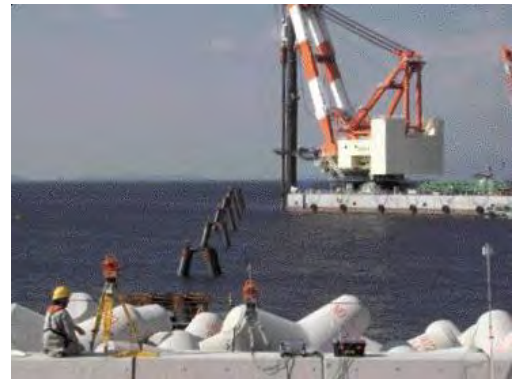
杭打設への適用事例
