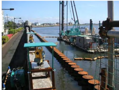
地盤改良への適用事例
